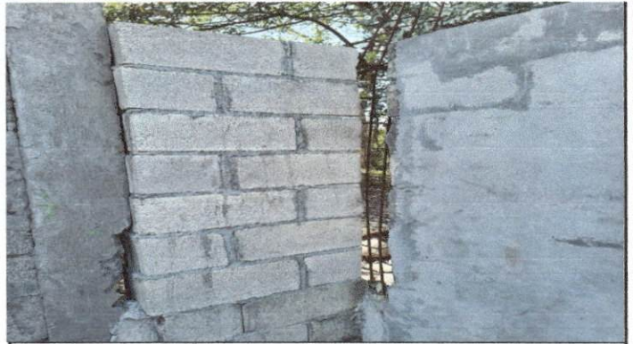
Foto 14: Reparación de muro perimetral de block
